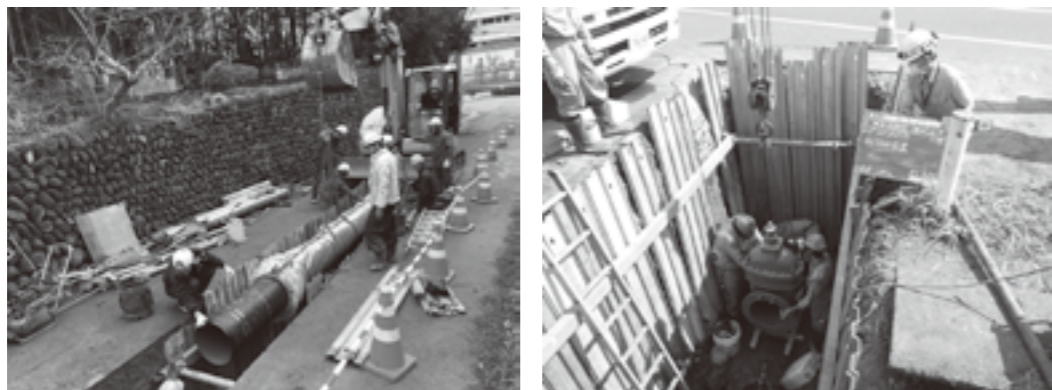
新しい水道管に更新する工事
