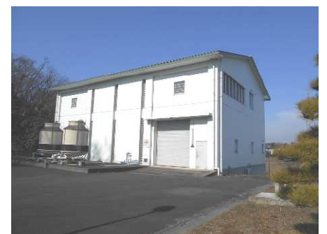
市野川雨水ポンプ場
