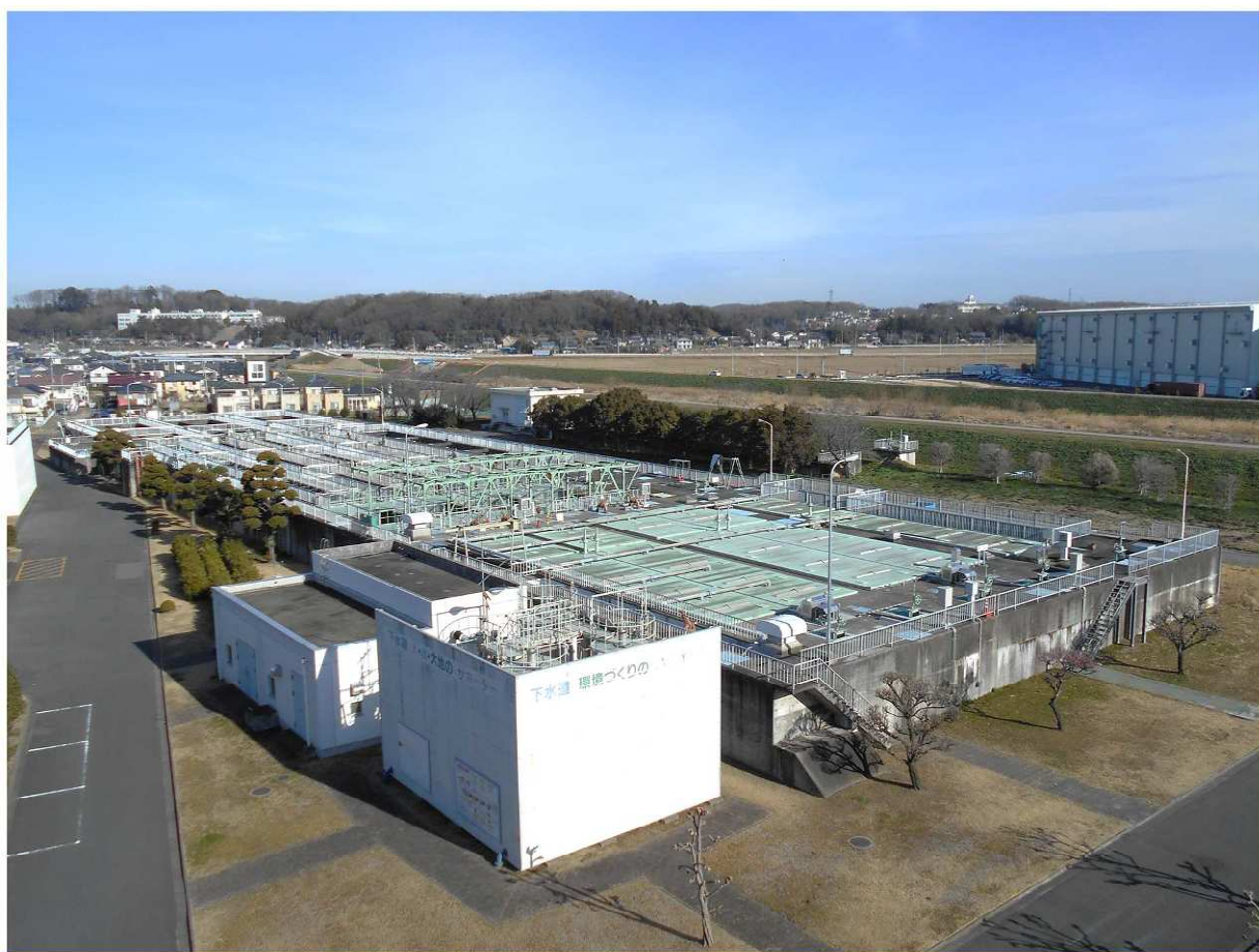
市野川浄化センター水処理施設
