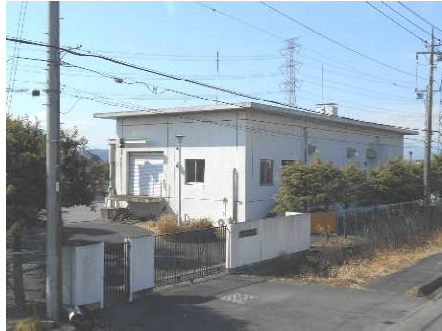
新江川第一下水中継ポンプ場
