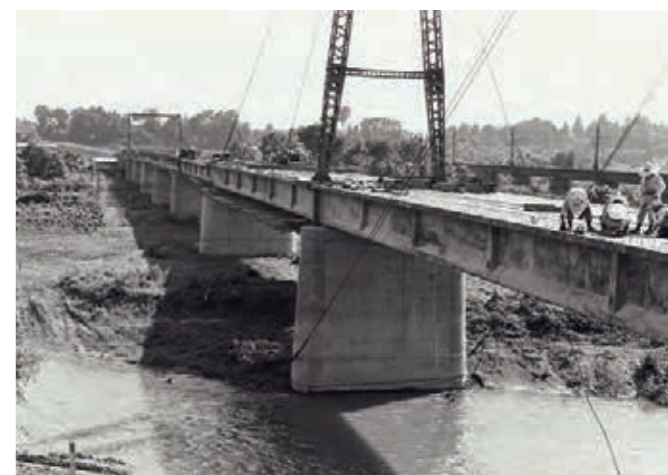
建設中の東松山橋
