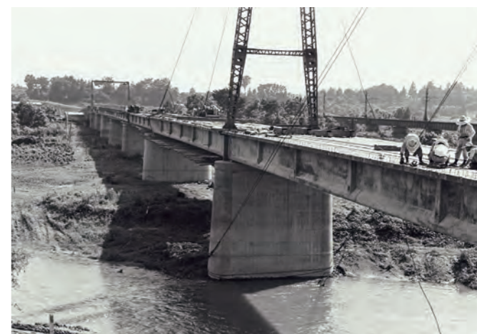
建設中の東松山橋
