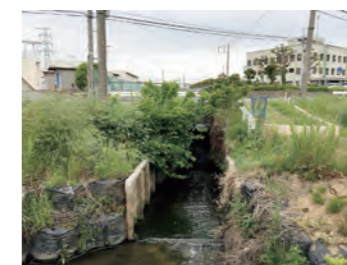
工事前の橋(7-35号橋)
