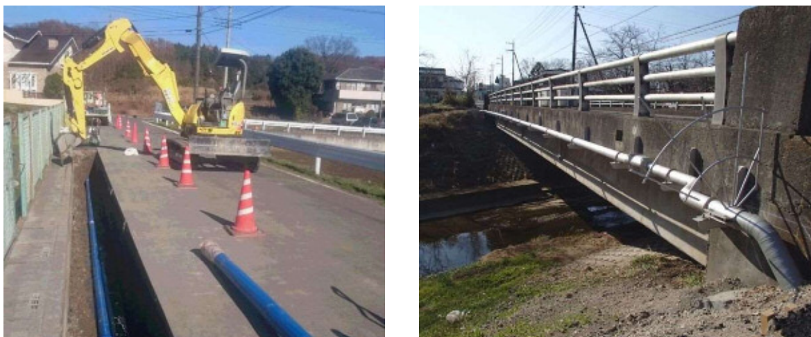
図 2-7 老朽管更新工事の様子、及び水管橋の様子
