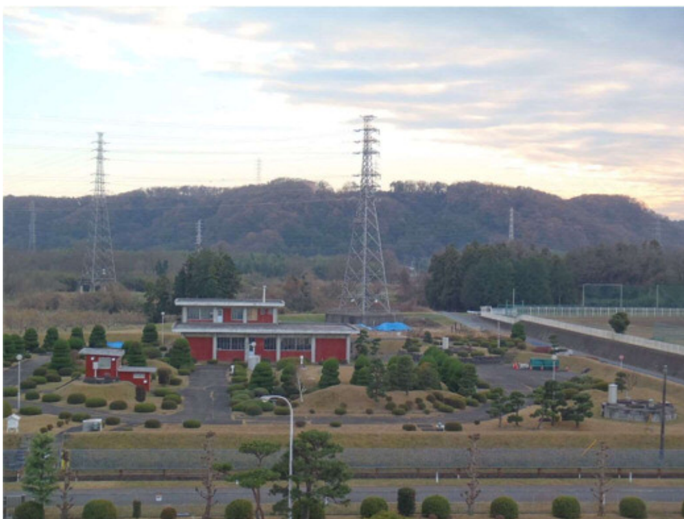
図 2-5 第一浄水場の様子
