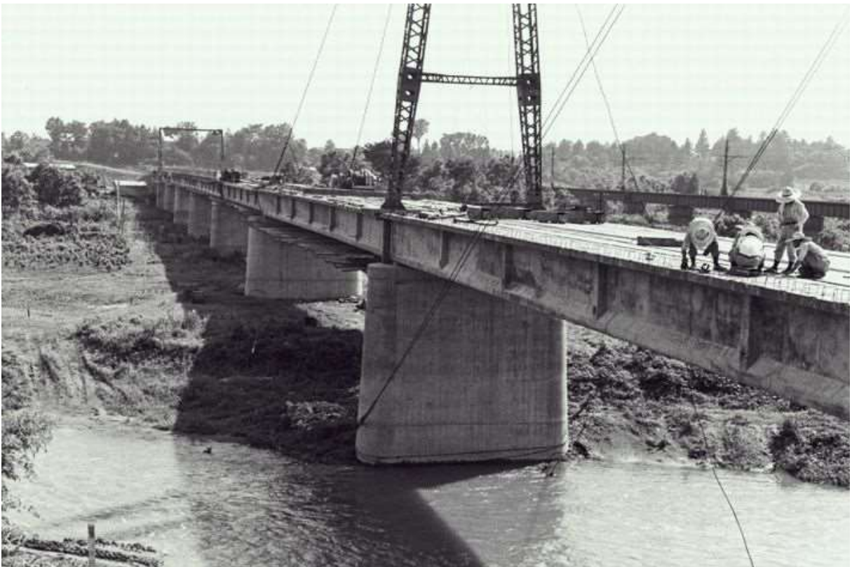
(4) 東松山橋工事（昭和 38 年）
