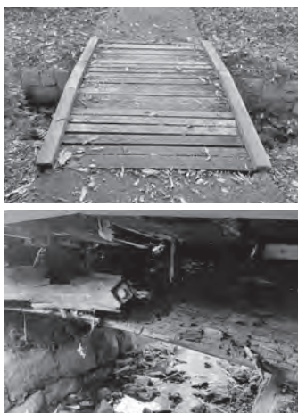
改修予定の橋
