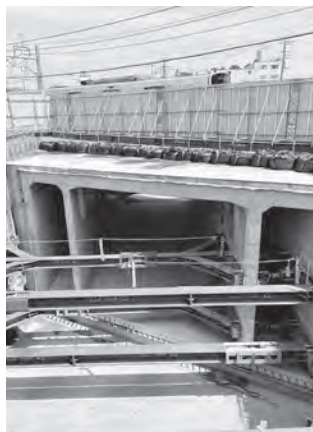
R3松高前通線 道路築造工事予定地
