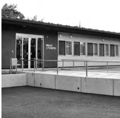
上下水道庁舎(山崎町)
