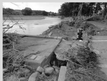
鞍掛橋 右岸側
