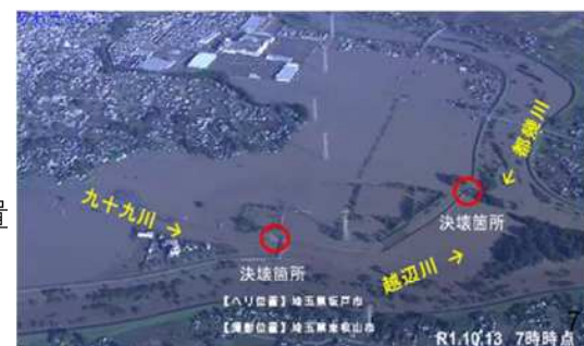
入間川流域における浸水被害状況
