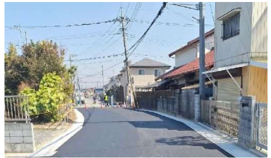
市道第6094号線【工事完成後】
