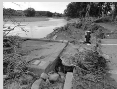
鞍掛橋 右岸側
