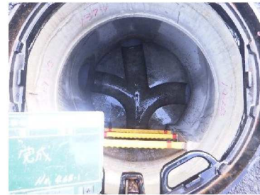
【マンホールの中】
