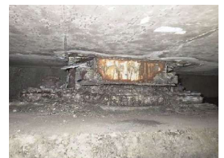
主桁・横桁・支承部の腐食,防食機能の劣化
