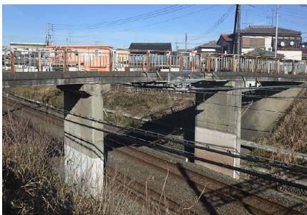
6-4号橋（健全度Ⅲ）
