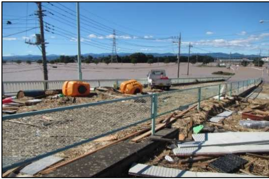
(県道岩殿観音南戸守線 早俣橋)
