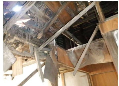
実際に市の補助金を受けて除却した空き家
