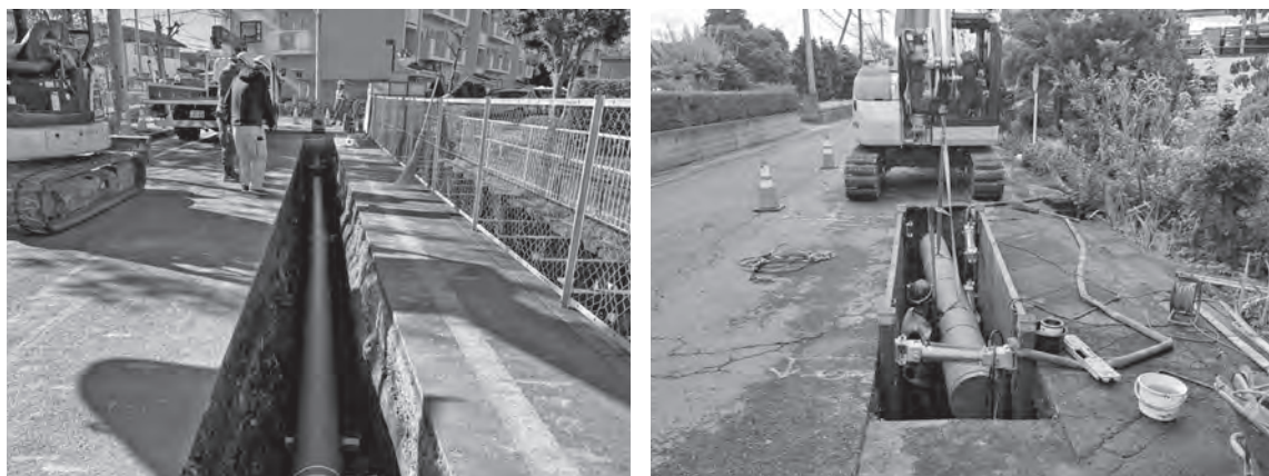
新しい水道管に更新する工事
