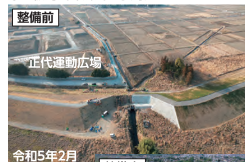
②一級河川都幾川 こつぎひかん 小剣樋管
