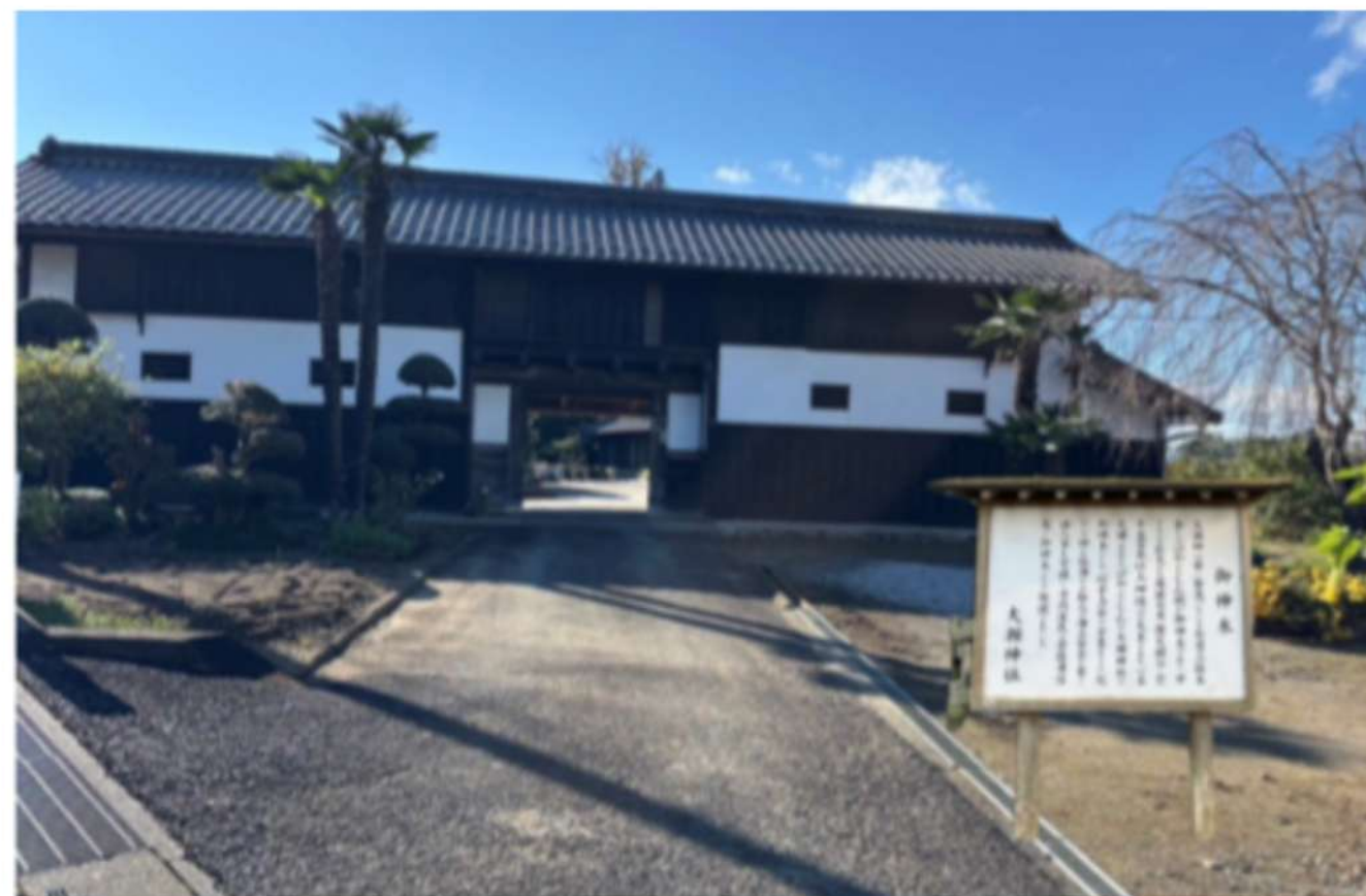
立て看板設置後
