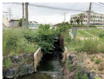
工事前の橋(7-35号橋)
