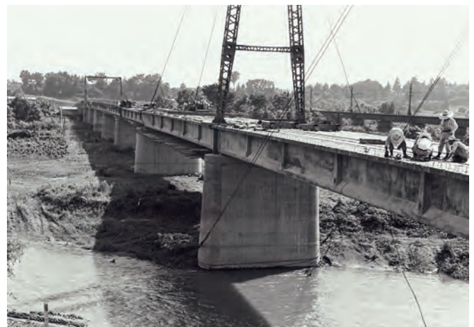
建設中の東松山橋
