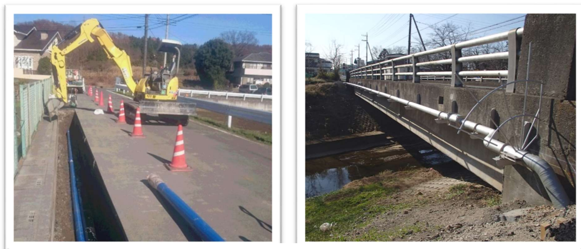
図 2-7 老朽管更新工事の様子、及び水管橋の様子
