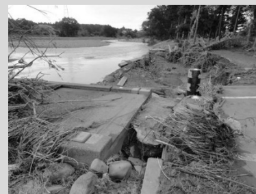
鞍掛橋 右岸側
