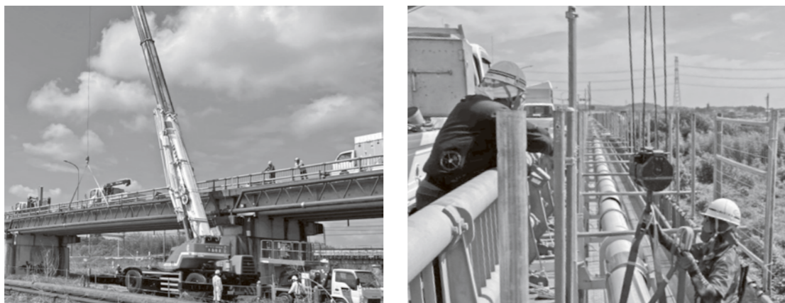
新しい水道管に更新する工事
