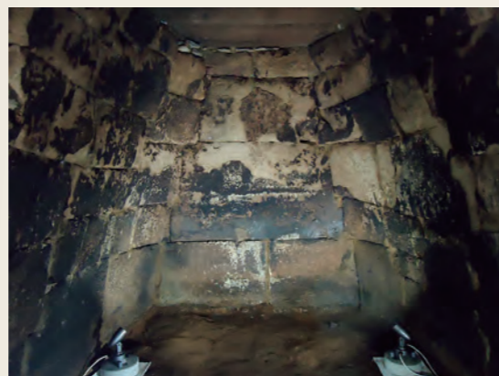
石室の内部と石組み
