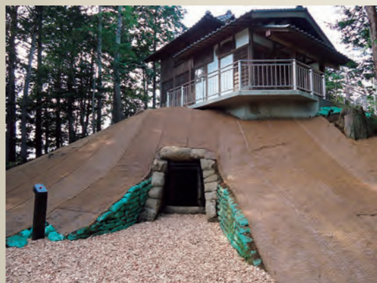
古墳全景と石室入口
