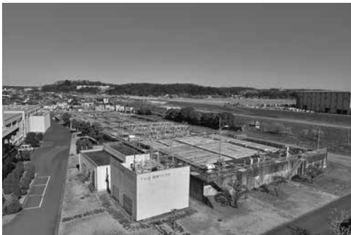
市野川浄化センター
