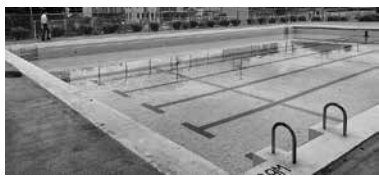
松山第一小学校のプール
