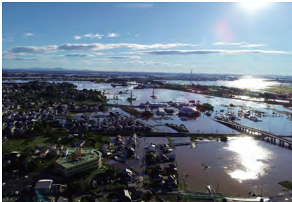
令和元年東日本台風による被害 (九十九川流域)
