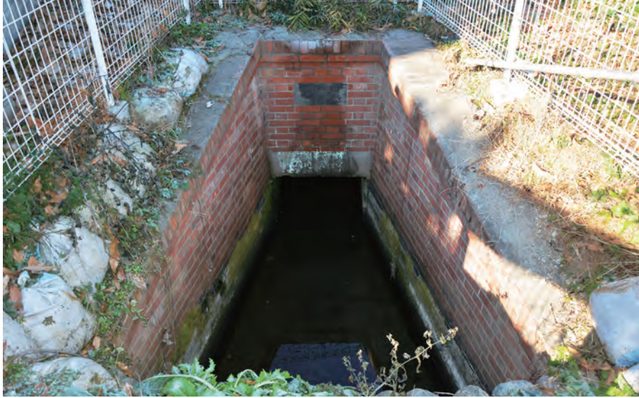
レンガ樋管（永傳樋管）
